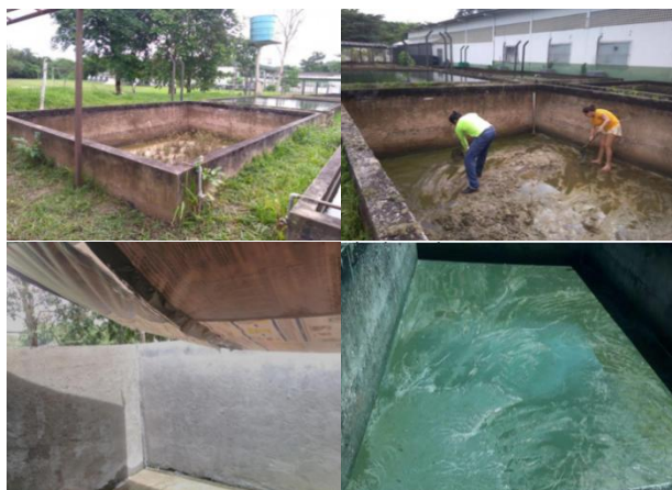
Figura 01 - Tanque destinado ao projeto, e seus processos de reforma
